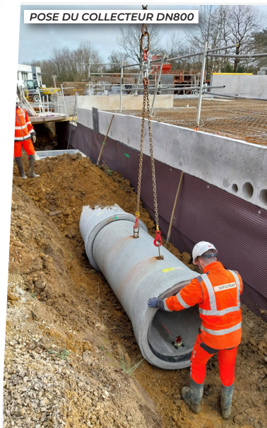
POSE DU COLLECTEUR DN800
