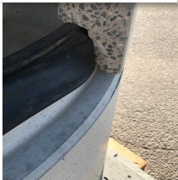
Aperçu de mise en place du joint
