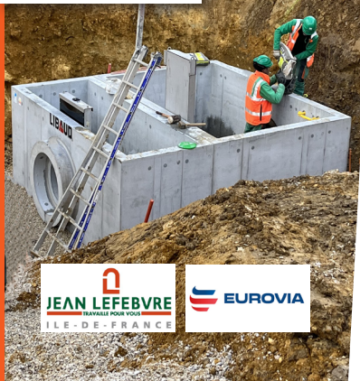
OUVRAGE DE RÉGULATION
