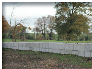
Zone de stockage
