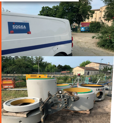
VUE D'ENSEMBLE DU CHANTIER
