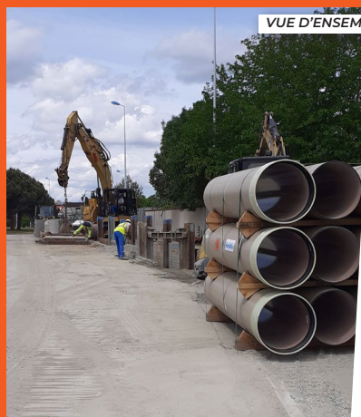
VUE D'ENSEMBLE DU CHANTIER
