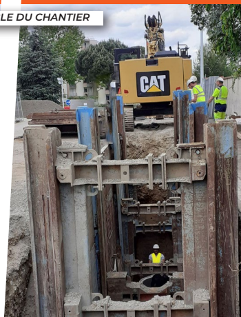
MISE EN PLACE D'UN REGARD
